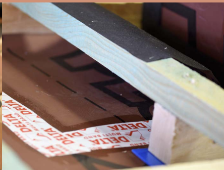
Vytvorenie odvodňovacieho žliabku
