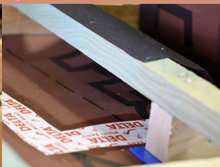
Vytvorenie odvodňovacieho žliabku
