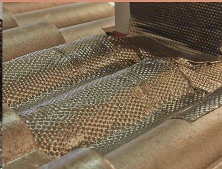
Dokončená zadná časť
