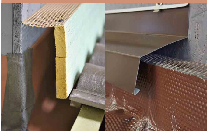
Detail napojenia fólie
